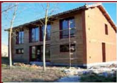
Conception et réalisation de maison en structure bois
